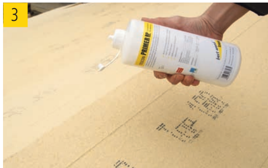
(3) TESCO PRIMER RP mit Pinsel (4) oder Auftragswerkzeug TENAPP (5) in Klebebandbreite auf die TOP auftragen.
