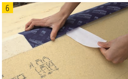
(6) TESCO VANA Klebeband auf Anschlussfuge in den trockenen oder nassen Primer verkleben und fest anreiben.
