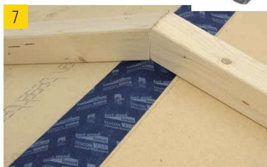
(7) Firstanschluss abgeklebt und Holzfaserplatten mit Konterlatten befestigt.
